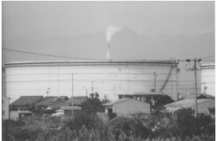
このタンク事故は分かっているだけで2回ある。一つは1973年(昭和48年)6月29日、鈴鹿川に一番近いタンクへのパイプの付け根のところが破裂、会社発表でも約20キロリットルの原油が噴出した。20キロといえば石油缶で千本以上、しかも原油のなかにはプロパンガスが3パーセント近くとガソリン・灯油などすぐ火のつくものもあり、その日は梅雨時の小雨模様でことなきをえている。もう一つは、硫黄分の多い南米産の原油貯蔵タンクでバクテリアによって穴が開けられそこから油が漏れ出した事故があった。
